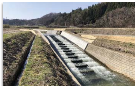
農業水利施設魚道整備促進事業 堅田地区（田子町、H27～R1） 頭首工及び魚道の改修
