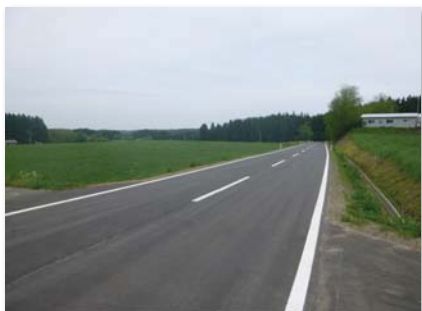
通作条件整備事業 五戸台地地区（五戸町、H27～R3） 基幹農道の路面改良
