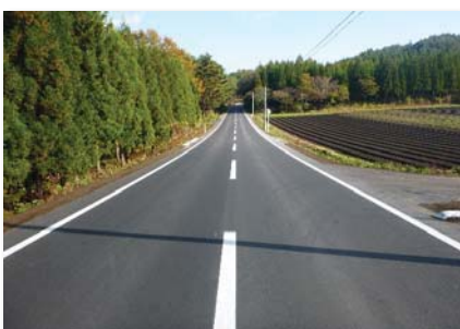
通作条件整備事業 新郷地区（新郷村、H23～R1） 基幹農道の路面改良
