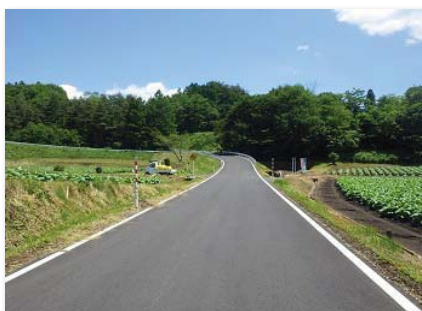
通作条件整備事業 丹内地区（三戸町、H27～H29） 基幹農道の路面改修
