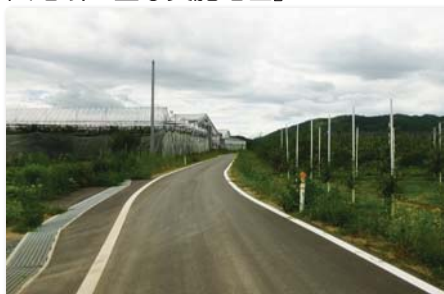
中山間地域総合整備事業 南部町地区（南部町、H22～R2） 農道の整備
