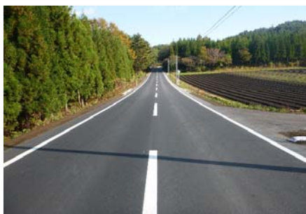
通作条件整備事業 新郷地区（新郷村、H23～H31） 基幹農道の路面改良
