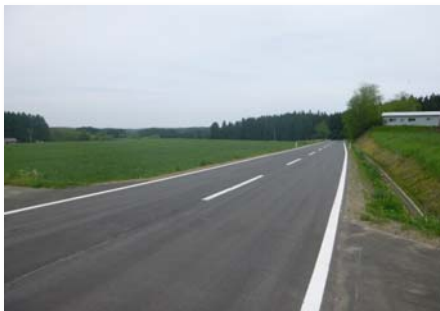
通作条件整備事業 五戸台地地区（五戸町、H27～H33） 基幹農道の路面改良
