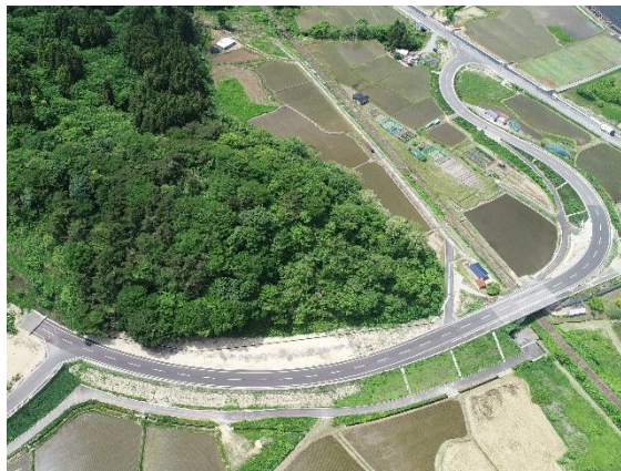
広域営農団地農道整備事業 道路工 (西海岸関地区 深浦町 H28～R4)
