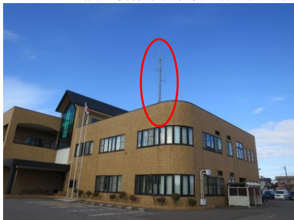
農地耕作条件整備事業 GNSS 基地局設置 （西津軽スマート地区 つがる市 R2～R3）
