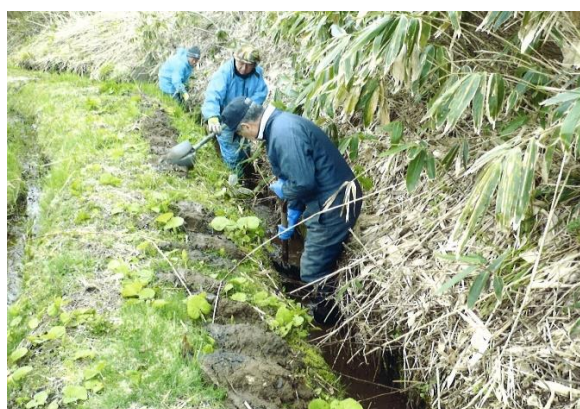
水路の泥上げ
