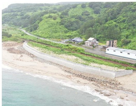
海岸保全施設整備事業
