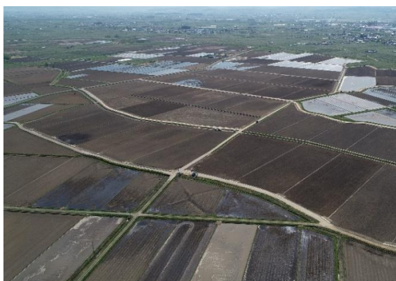
経営体育成基盤整備事業 (深味長野地区 板柳町 R2～R7)
