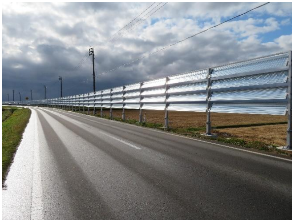
通作条件整備事業 防雪柵工 (五所川原地区 五所川原市 R1～R5)
