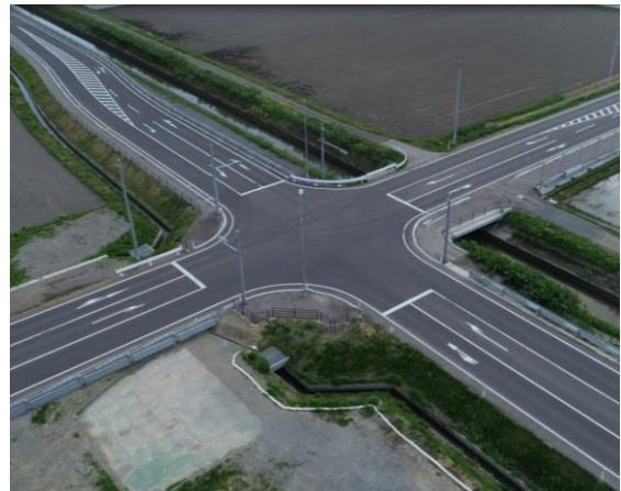
通作条件整備事業 舗装工 (津軽北部地区 つがる市 H25～R2)
