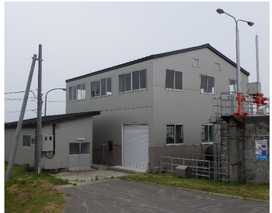
県営小田川南部地区農業水利施設保全合理化事業により整備を行っている金木排水機場
