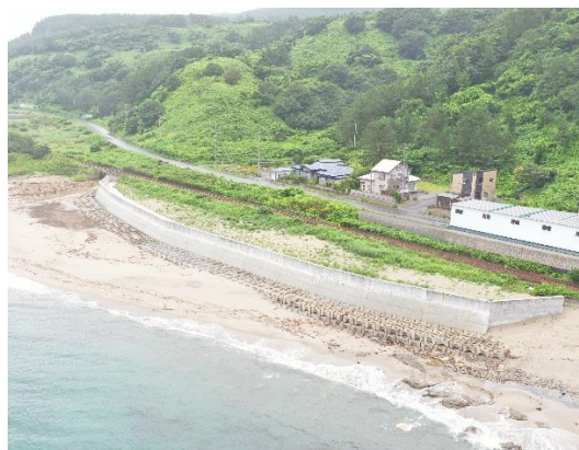
海岸保全施設整備事業 (大間越地区 深浦町 H24～R4)
