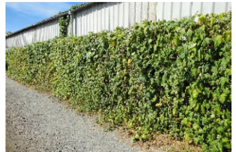
植物や遮光ネットの設置
