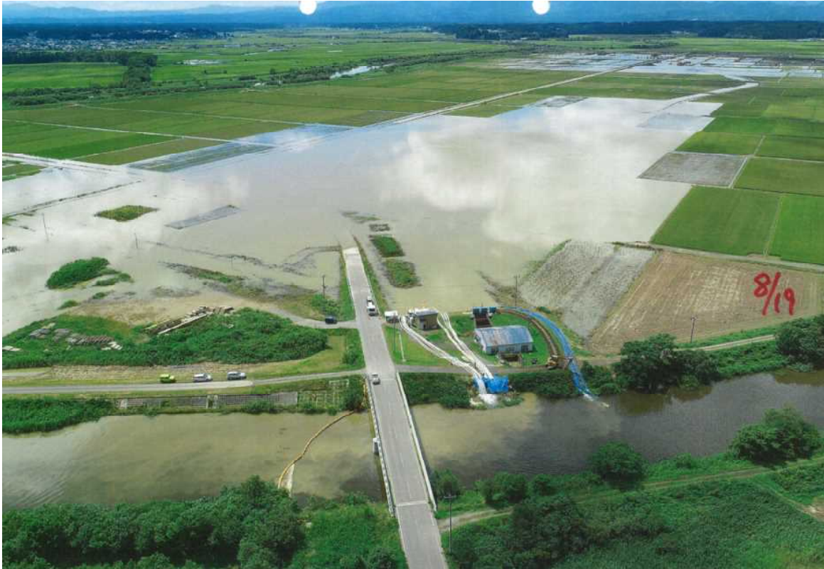
8月19日現在の冠水状況（中央部分が10日以上冠水ほ場、東北町役場撮影）
