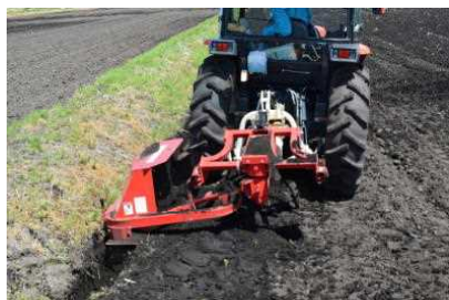
実証ほの額ぶち明きょ施工
