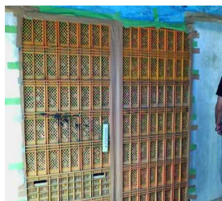
赤外線サーモグラフィー（右）によるシート 乾燥の状況（左：温度ムラがなく、適切な管理）
