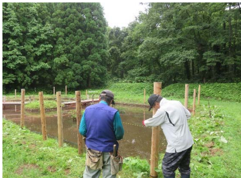
転落防止柵の設置作業
