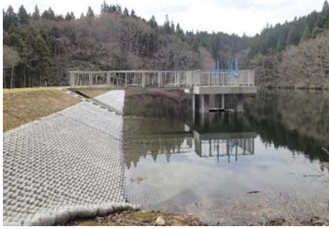
ため池等整備事業 下小国たかのご地区（外ヶ浜町、H26～H29）
