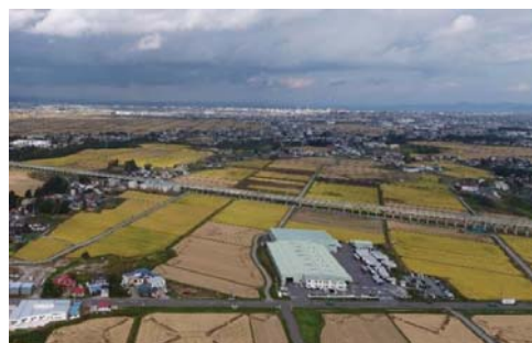
経営体育成基盤整備事業 荒川中部地区（青森市、H25～H30）
