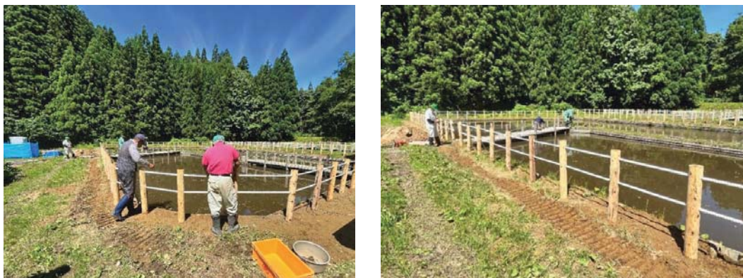
転落防止柵の設置作業の様子
