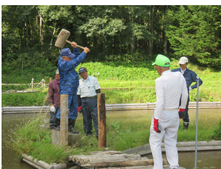
支柱を打ち込む様子
