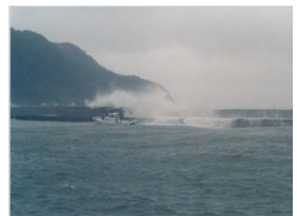
港内の静穏度を上げるため防波堤嵩上げ、 護岸改良工事を実施 (平館地区漁港機能強化事業：外ヶ浜町)
