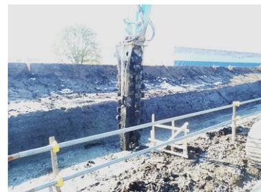
パワーブレンダー工法による地盤改良の様子
