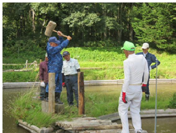
支柱を打ち込む状況
