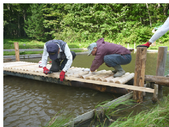
丸太を設置する状況
