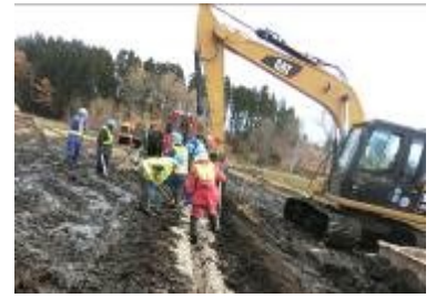
暗渠排水の施工状況
