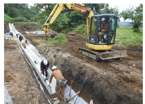
作業状況 (山腹明渠工)
