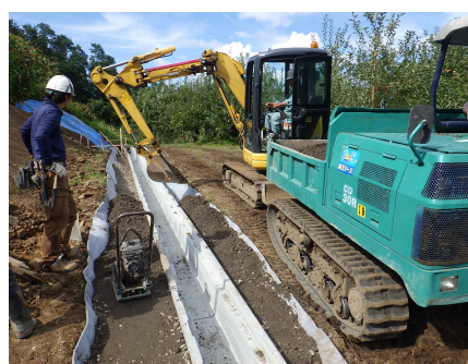
作業状況 (山腹明渠工)
