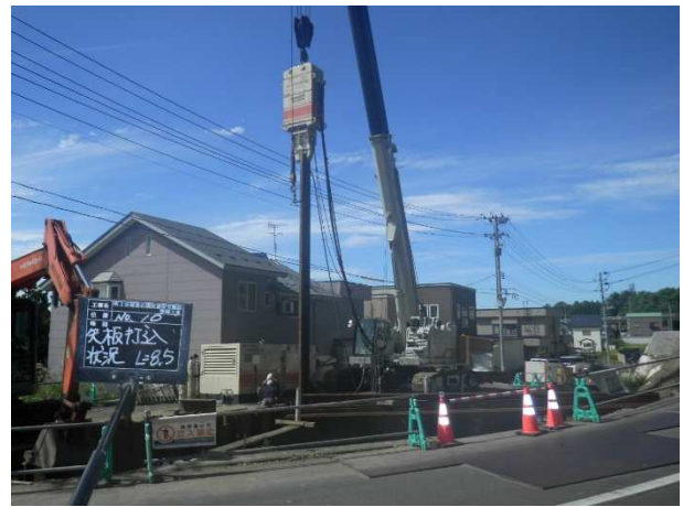
振動を抑えた矢板の打ち込み
