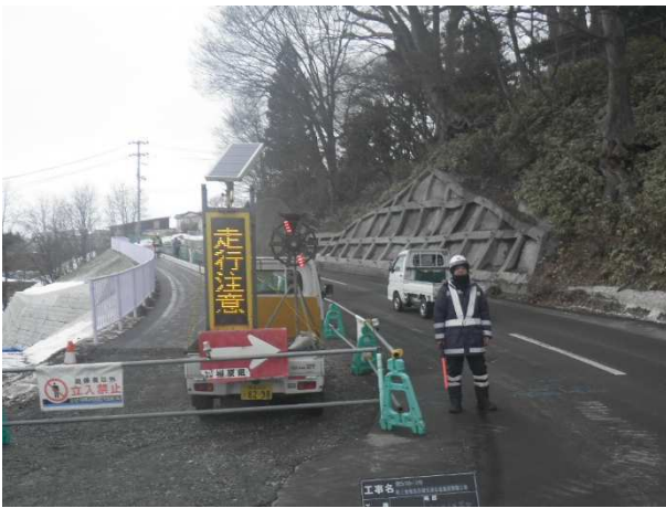
電光掲示板の設置
