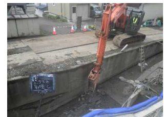
コンクリート破砕
