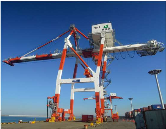
橋型クレーン
