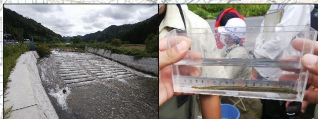
③大滝堰地区で整備した魚道 (希少種であるスナヤツメの生息も確認された)
