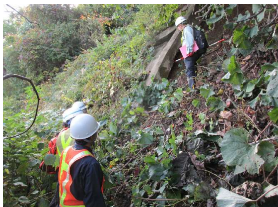
点検状況(点検者全員による合同点検)
