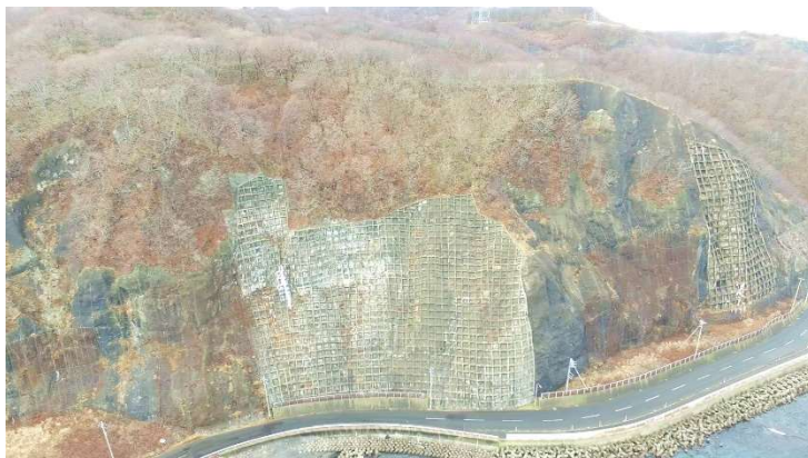
UAVを用いた点検
