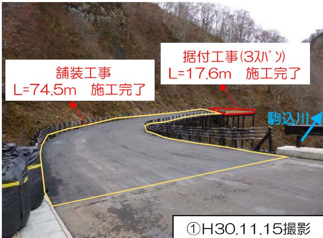
駒込川上流部に建設中の4号工事用道路では、舗装工L=74.5mの施工が終わり、据付工事（3スパン）L=17.6mの追加施工も含め今年度の工事が完成しました！！
