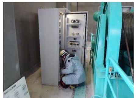
取水塔内の電気操作盤点検状況
