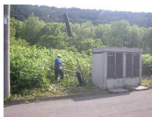
現場周辺の草刈り
