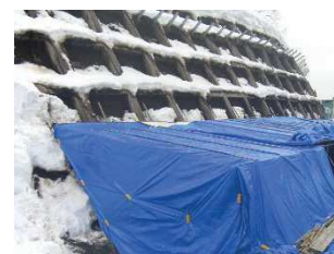
法面除雪・養生小屋設置
