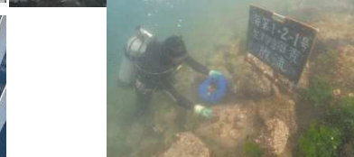
施工範囲内の水生生物の生息状況を調査・記録のうえ保護対策を立案し貝類やアマモ等の移植を実施
