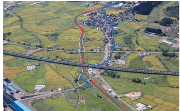
天田内川総合流域防災事業
