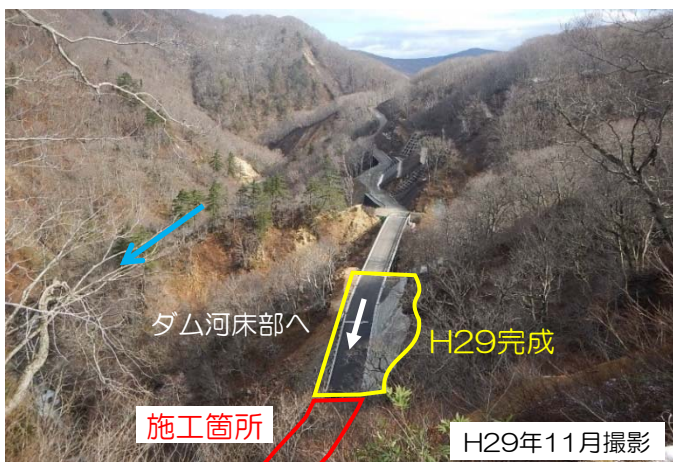
写真① 1号工事用道路からの眺め
