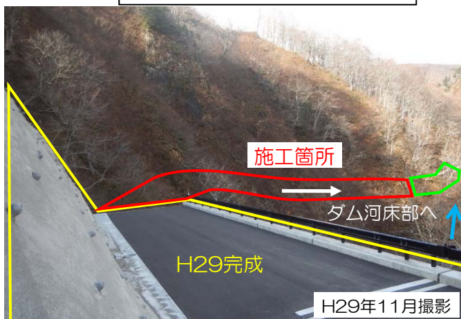
写真② 急峻な地形となっており、施工時は要注意！
