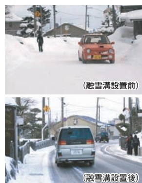
国道280号凍雪害防止事業(青森市大字飛鳥工区)
