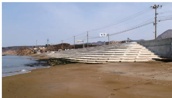
大泊海岸堤防老朽化対策緊急事業
