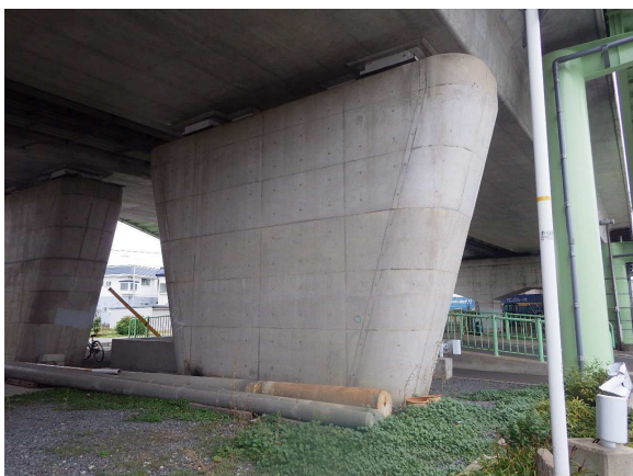
・ 着工前（橋脚耐震補強工事）
