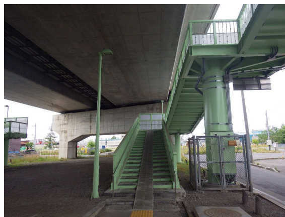
・ 完成（歩道橋部分補修工事）
