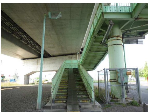
・ 着工前（歩道橋部分補修工事）
