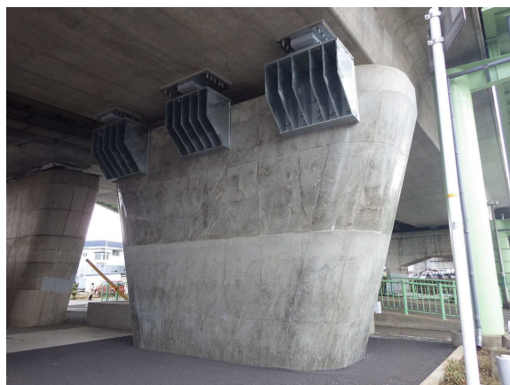
・ 完成（橋脚耐震補強工事）
