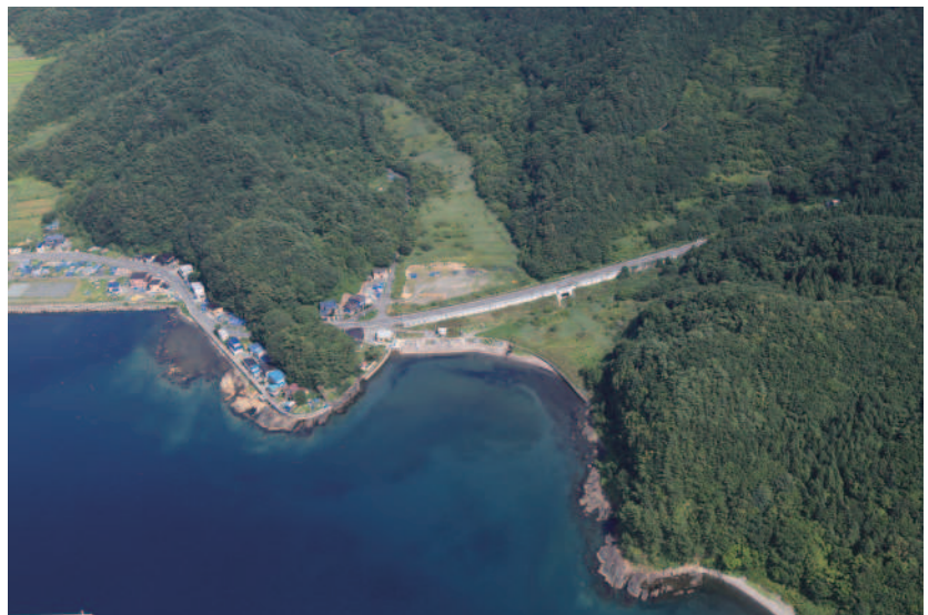
馬屋尻海岸 海岸堤防老朽化対策緊急事業
