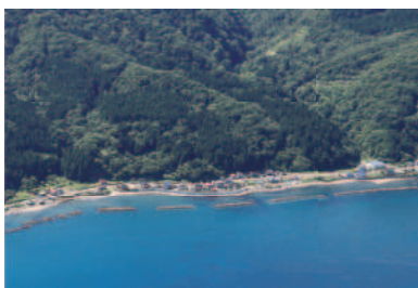
石崎海岸 海岸堤防老朽化対策緊急事業
