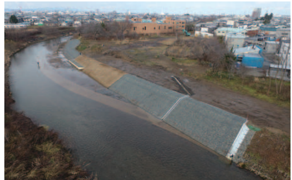
堤川(駒込川)流域治水対策河川改修事業 完成
