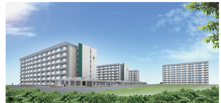
県営住宅小柳団地4号棟建設工事
