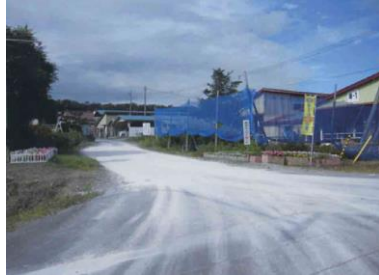
消石灰による石灰帯
