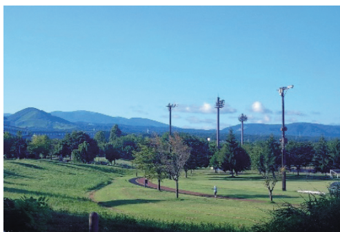
土木施設部門 特別賞 「青森市スポーツ広場」
