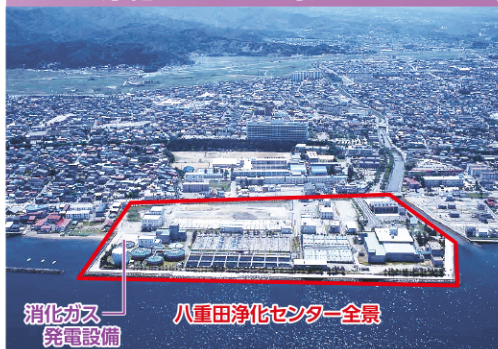
八重田浄化センター全景
