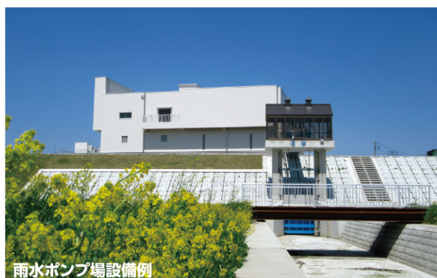
八戸市 尻内雨水ポンプ場
