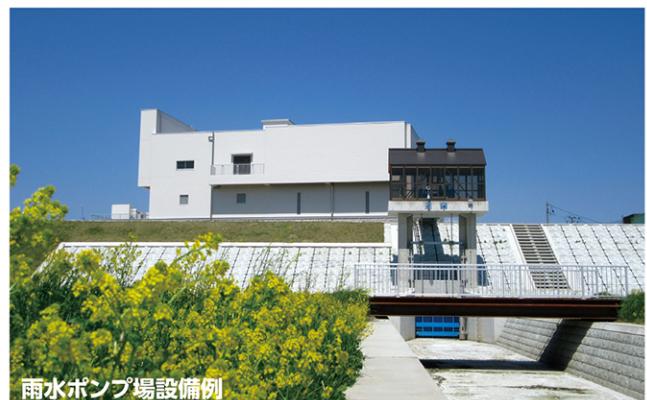
八戸市 尻内雨水ポンプ場
