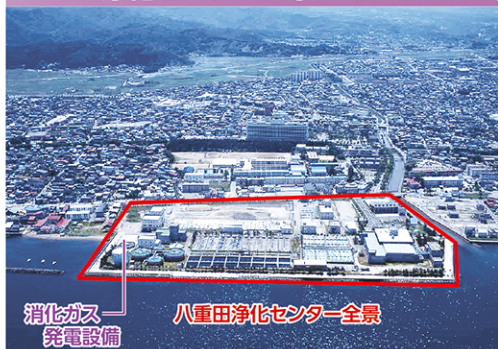
八重田浄化センター全景
