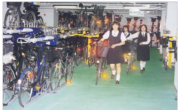
弘前駅前地下自転車駐車場 (弘前市)
