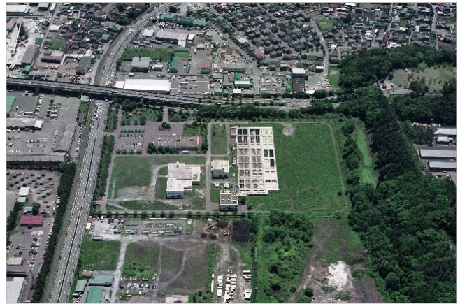
馬淵川浄化センター全景（八戸市）
