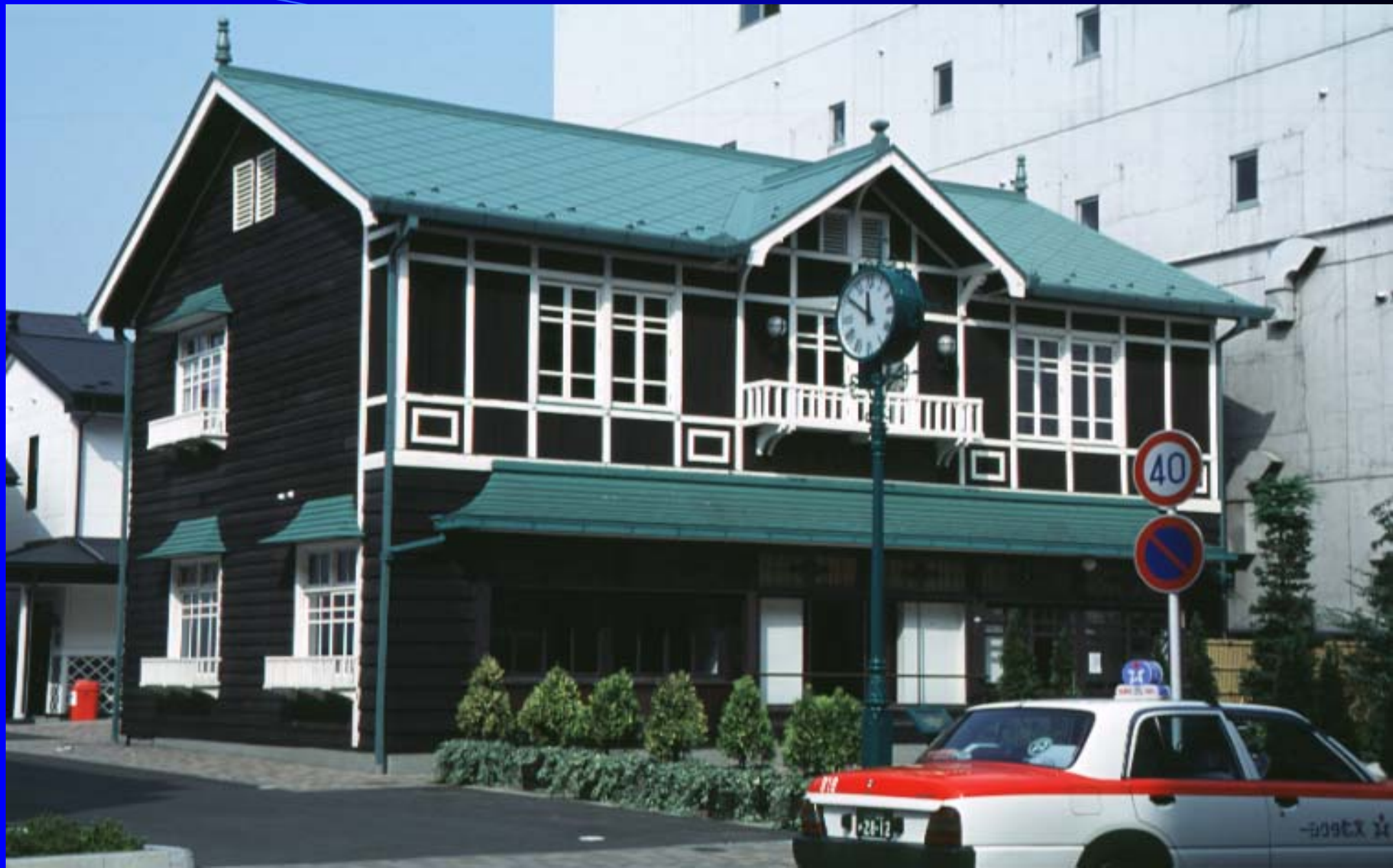
八日町の旧河内屋（県内初の登録文化財 残したい建物 1）
