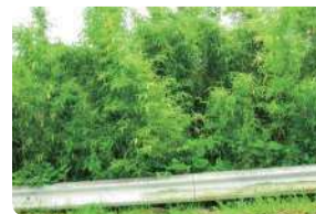
道路にはみ出した雑木
