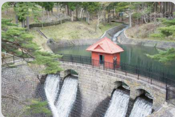
むつ市 水源地公園 アーチ式ダム
