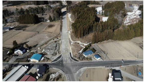
国道394号(榎林バイパス)工事(七戸町)
