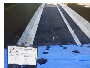
舗装完了状況（終点側）
