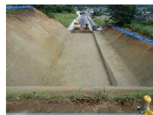
掘削完了状況（終点側）
