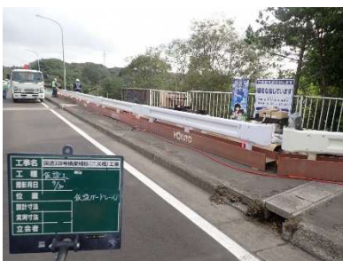
高欄撤去時の仮設ガードレールを使用した転落防止対策
