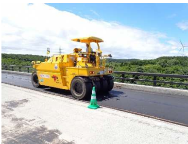
舗設時緊急自動ブレーキ搭載型ローラ を使用し、作業員等の安全を確保
