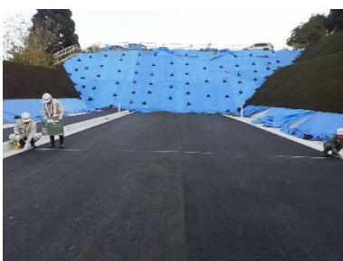
⑤ 砂質土法面のシート養生
