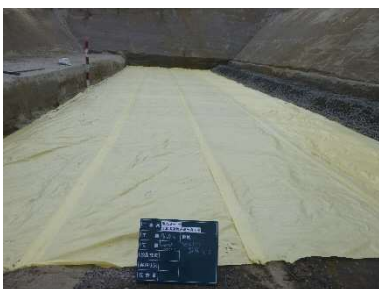
③ 碎石置換工下面へのシート敷設
