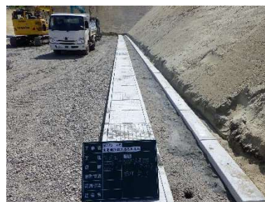
④ 張コンクリートの碎石床付け
