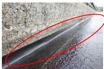
止水テープ 設置状況 ビタッとL型止水テープ（NETIS）
