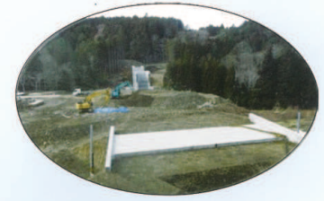
古野・大川目線(県代行)事業 施工状況
