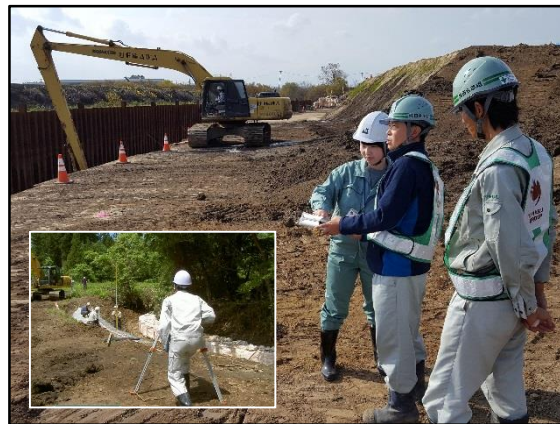
【施工検査の状況（出先機関）】
