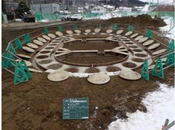
【鋼管矢板施工状況(中掘り工法)】【全自動警報機能付き軌道計測器】
