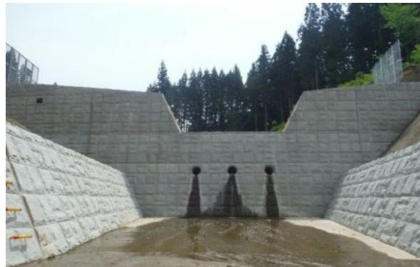
完成した 堆積工下流堰堤
