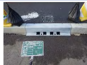
加工蓋設置完了
