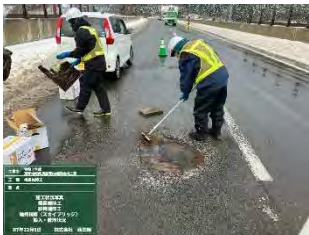
舗装補修状況
