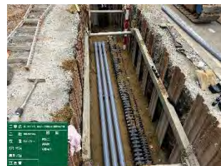
管路設置完了
