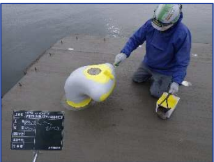
係船柱の塗装状況
