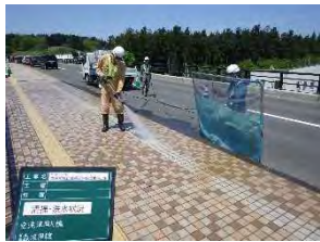
路面清掃状況
