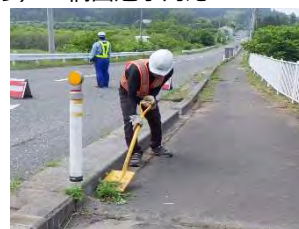
清掃工（土砂撤去）
