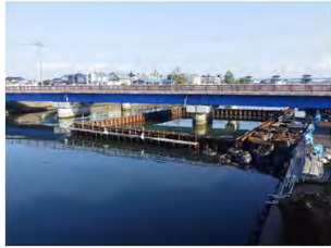
仮設工 鋼矢板設置
