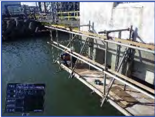
海上での足場組立
