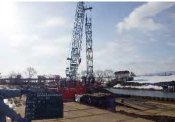
P3橋脚場所打ち杭（施工中）
