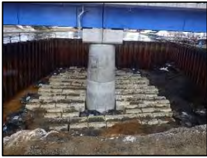
橋脚巻立て工 護床工
