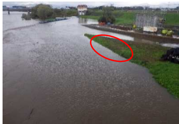
P3橋脚場所打ち杭施工ヤード増水状況
