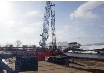
P3橋脚場所打ち杭（施工中）
