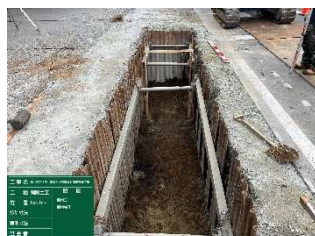
掘削・土留め
