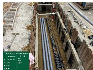
管路設置完了
