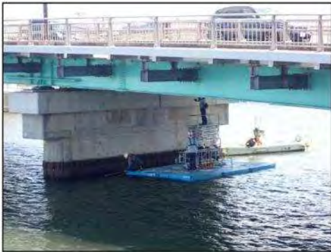
新技術（浮き足場式工法）を用いた橋梁点検状況
