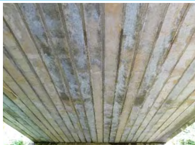
写真-1 釜屋沢橋桁下全景
