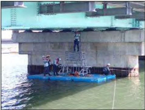
新技術（浮き足場式工法）を用いた橋梁点検状況
