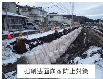
掘削法面崩落防止対策
