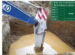
湧水箇所での地盤改良施工状況
