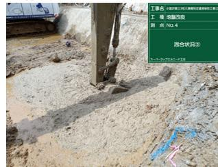
コンクリート堰堤と地盤改良の同時施工状況
