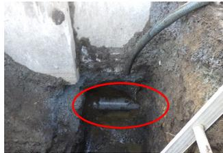
試掘により埋設管の支障が確認
