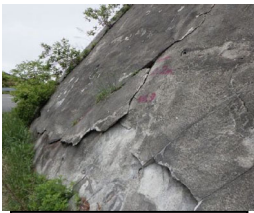
モルタル吹付部写真
