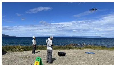
3次元点群測量状況（UAV搭載型レーザ）
