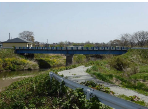
轟木橋 側面全景
