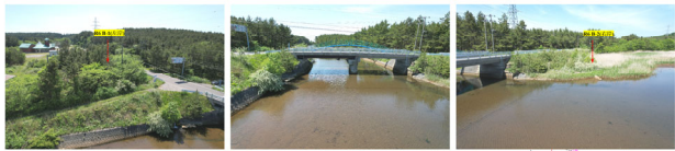
現場周辺写真
