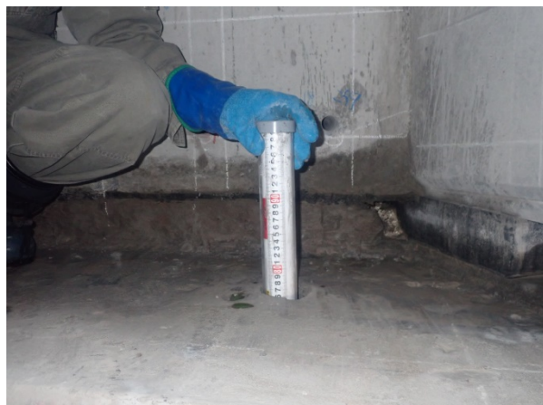
削孔長測定状況
