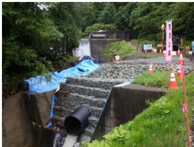
【割栗石及びフトンゴ設置】承諾事項
