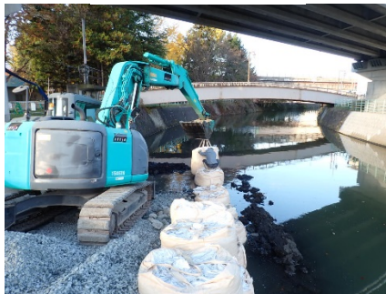
大型土のう設置
