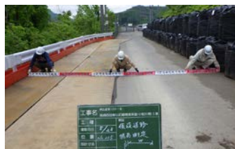
【砂子瀬ゲート拡幅工事】
