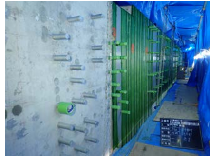
アラミド繊維貼付け
