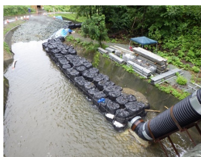
【大型土のう設置】承諾事項
