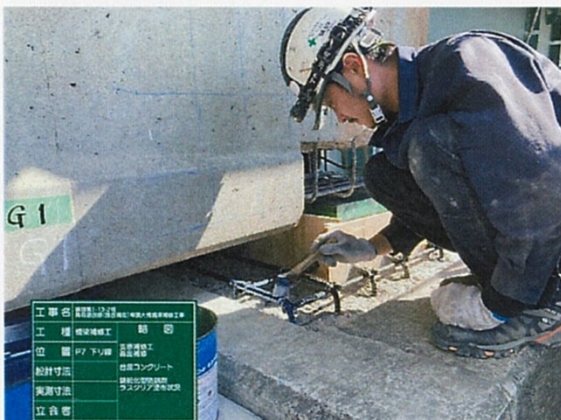
台座鉄筋塗布
