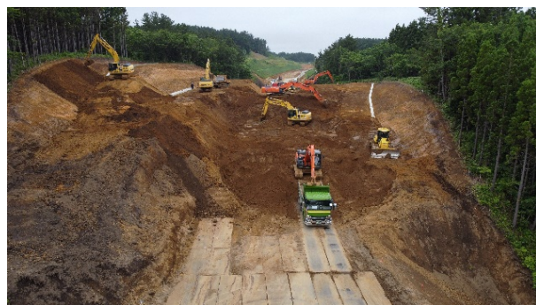
ICT活用による掘削状況
