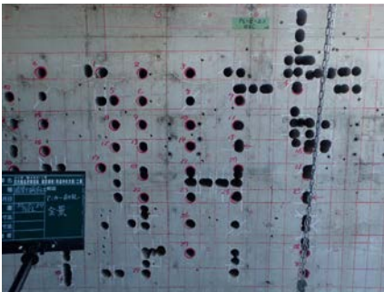
アンカー削孔
