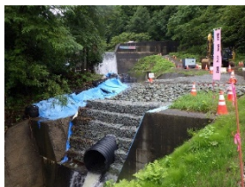
暗渠管の離脱防止対策
