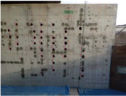
リフレモルセットによる不到達工補修
