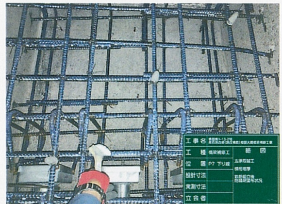
横桁増厚鉄筋塗布
