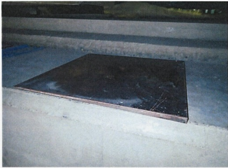
ジャッキの角度調整用金具の作成
