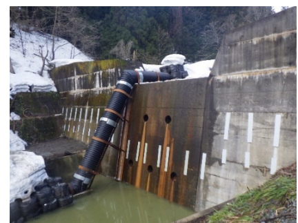
【落差部の架台取付】
