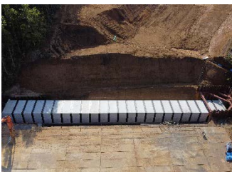
【PCボックスカルバート施工完了】
