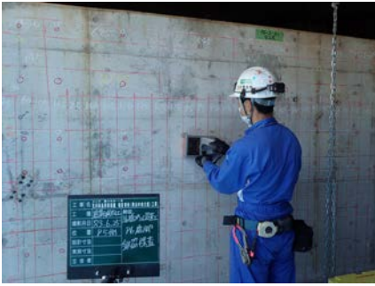
鉄筋探査
