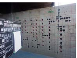
アンカー削孔
