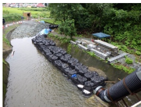
暗渠管の離脱防止対策
