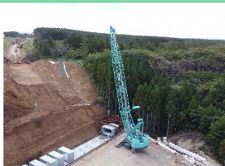
【PCボックスカルバート施工状況】
