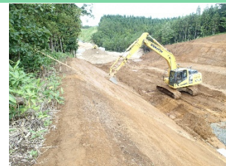
【ICT土工施工状況】
