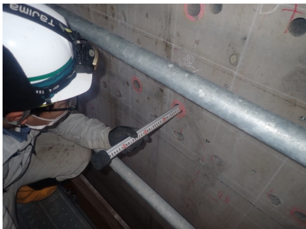
削孔長測定状況
