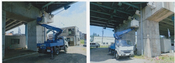
高所作業車による現場調査（ひび割れ、断面修復）状況
