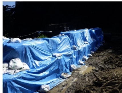
【シート張りでの漏水防止】
