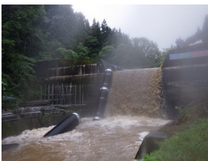
【大雨時の管浮き上り】
