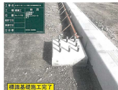
標識基礎施工完了
