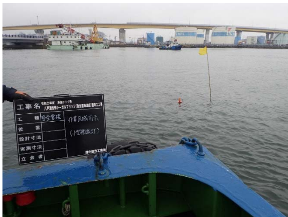
海上作業区域の小型標識灯の設置
