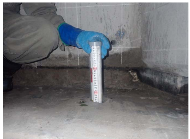
削孔長測定状況
