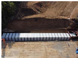
【PCボックスカルバート施工完了】
