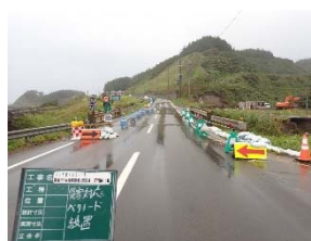
バリケード設置状況 (秋田側より撮影)
