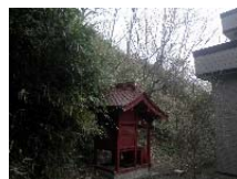
① 祠移設前（着工前）
