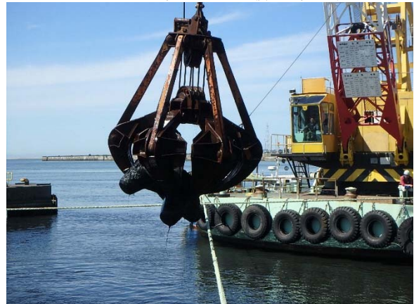
オレンジバケットによる消波ブロック撤去
