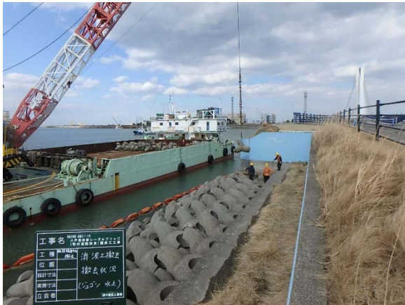
陸上部消波ブロック撤去
