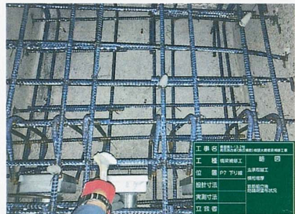
横桁増厚鉄筋塗布
