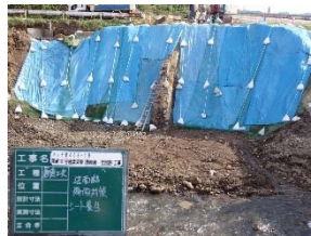
町道部法面保護対策
