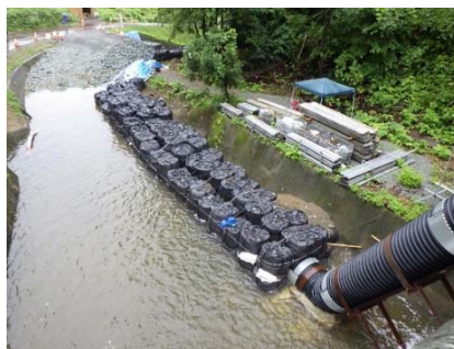
【大型土のう設置】承諾事項
