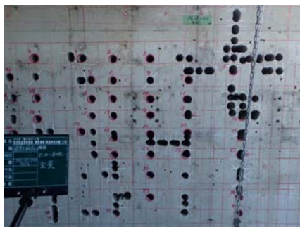
アンカー削孔
