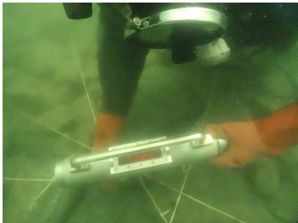
基礎捨石均し作業時の水中水準器使用
