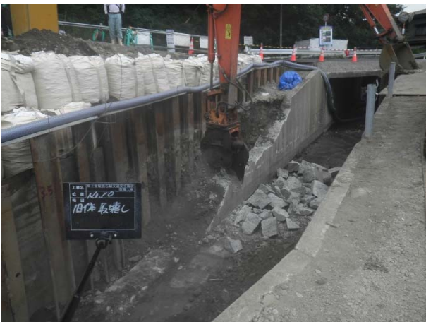
専用器具を使用し振動を抑えた破碎
