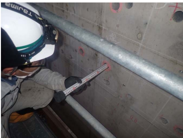
削孔長測定状況
