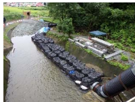
暗渠管の離脱防止対策
