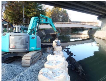
大型土のう設置
