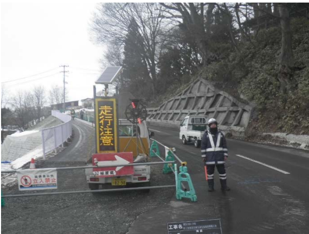
電光掲示板の設置
