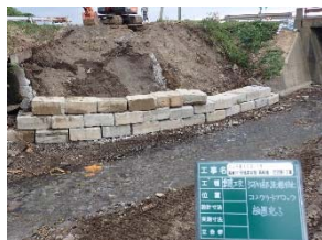
増水時の道路洗堀対策
