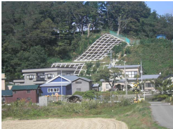
令和4年度施工完成（全景）
