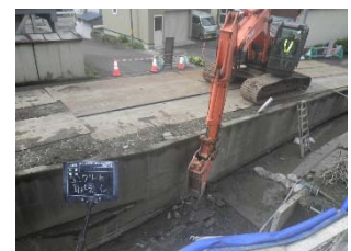
コンクリート破砕
