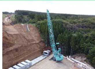
【PCボックスカルバート施工状況】
