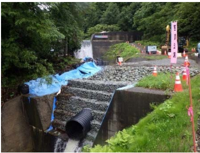
【割栗石及びトンカゴ設置】承諾事項
