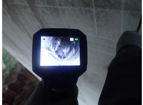
孔内確認状況
