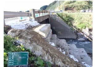
道路復旧完了
