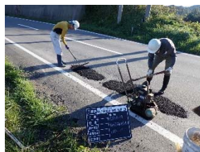
仮復旧舗設状況
