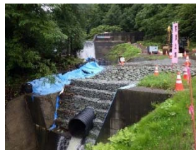
暗渠管の離脱防止対策
