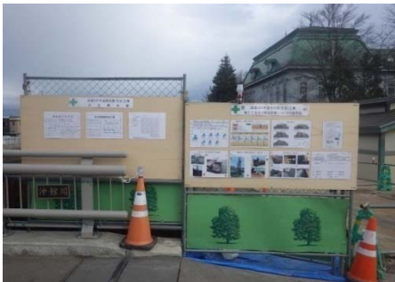
周知活動工法説明・作業工程掲示板
