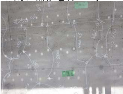
ひび割れ調査
