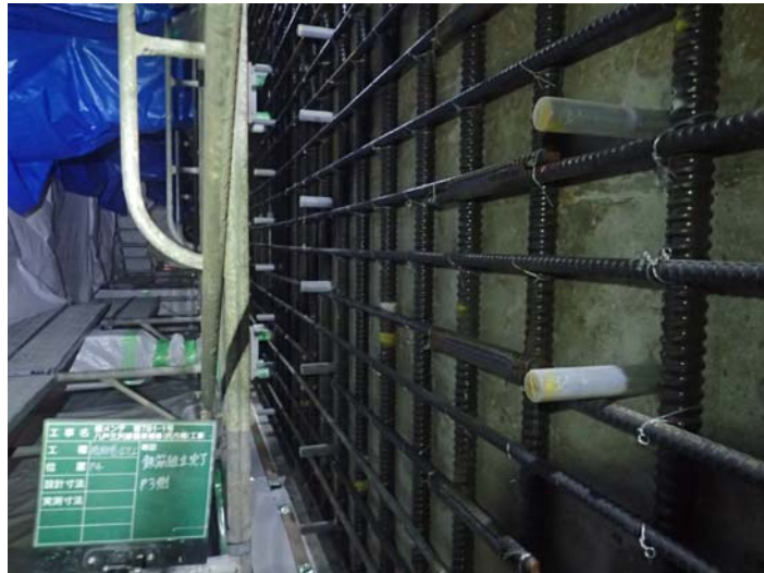
防錆処理鉄筋を使用した鉄筋組立状況
