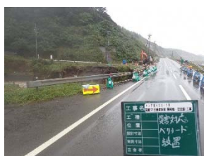
バリケード設置状況 (鱒ヶ沢側より撮影)
