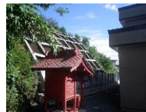
③ 元々の場所に再移設（法面施工後）
