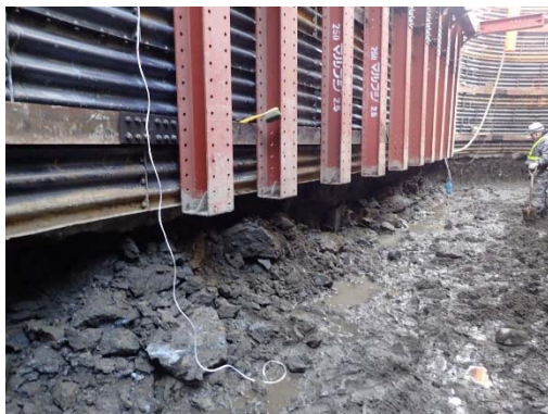
湧水による埋戻土の崩落状況
