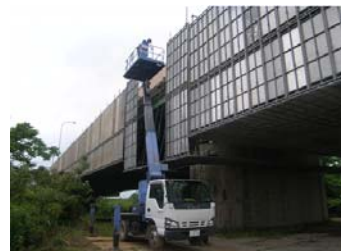
高所作業車使用で安全に足場設置
