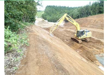
【ICT土工施工状況】
