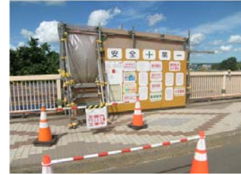
昇降階段・安全掲示板設置
