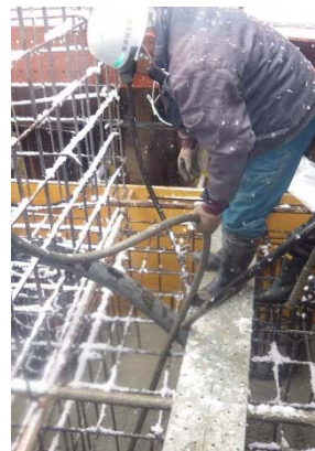
スパイラル型内部振動機使用
