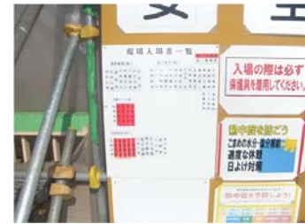
現場入場一覧表設置
