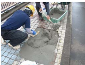
歩道部タイル舗装破損個所の補修作業
