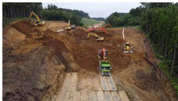
ICT活用による掘削状況
