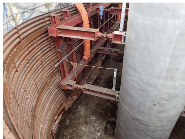
無人での解体実施
