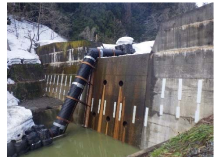
【落差部の架台取付】
