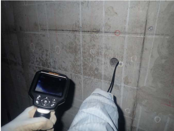
孔内確認状況
