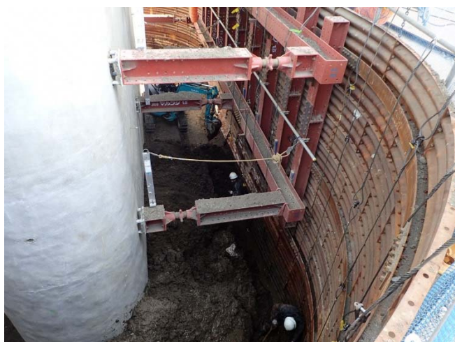
解体用ワイヤー装着
