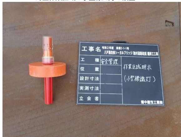
海上作業区域の小型標識灯の設置
