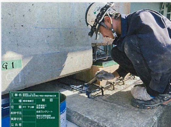
台座鉄筋塗布
