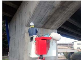
集塵機能付き工具での施工
