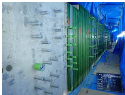
アラミド繊維貼付け
