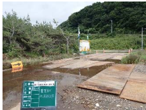
農業者への仮設道路設置
