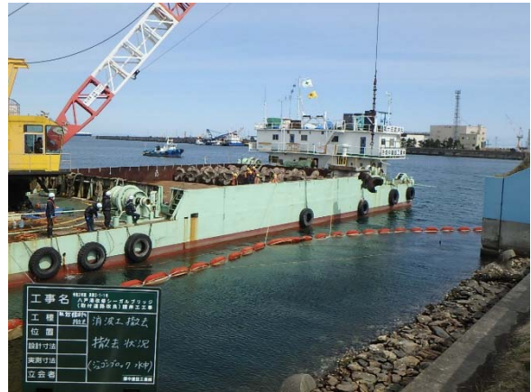
水中部消波ブロック撤去
