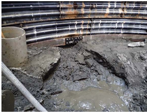
湧水による埋戻土の崩落状況
