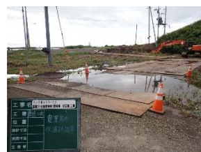
農業者への仮設道路設置
