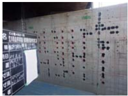
アンカー削孔
