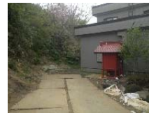
② 仮移転(法面工事中)
