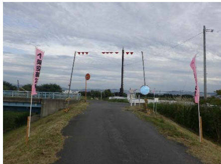
高さ制限簡易ゲート設置状況 藤崎橋(伐採時)現場出入口
