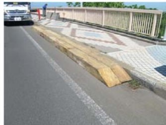
木製簡易設置によるスムーズな乗入れ
