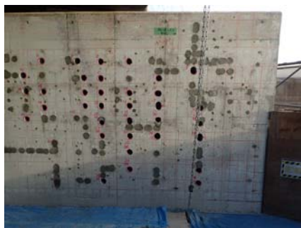
リフレモルセットによる不到達工補修
