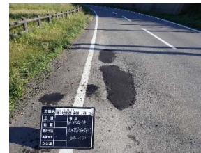
舗装仮復旧完了
