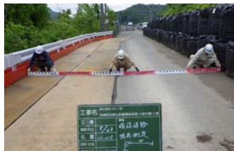
【砂子瀬ゲート拡幅工事】
