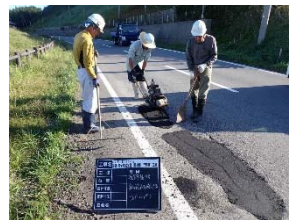
仮復旧舗装転圧状況
