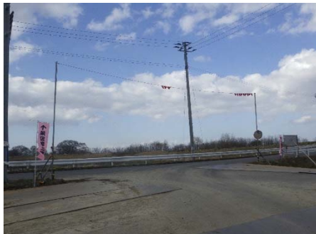
藤崎橋現場出入口
