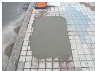
歩道部タイル舗装破損個所の補修作業
