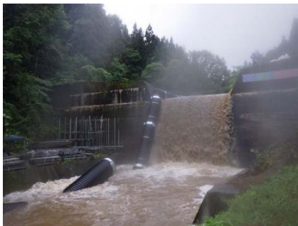
【大雨時の管浮き上り】
