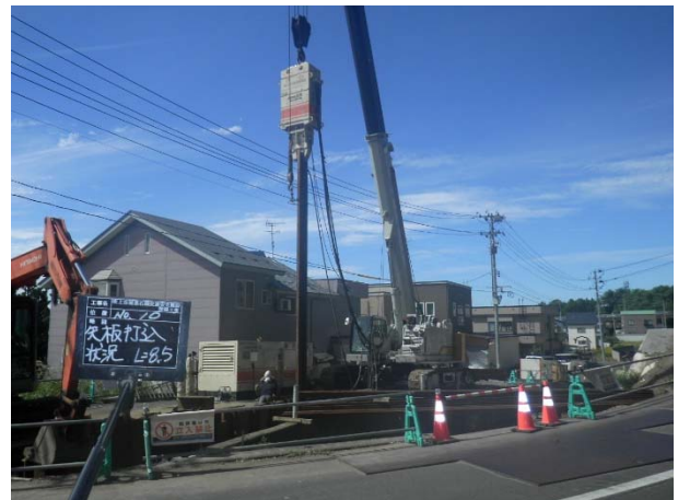
振動を抑えた矢板の打ち込み
