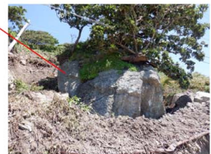
大規模落石⇒小割除去
