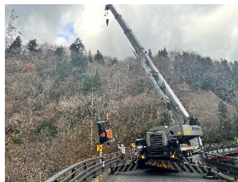
クレーンによる掘削機械の吊降し
