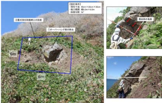
図 3-6 露岩① 対策工範囲全景写真
