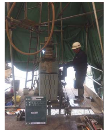
調査ボーリング 掘進状況
