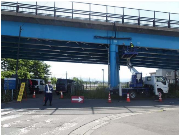
点検状況写真
