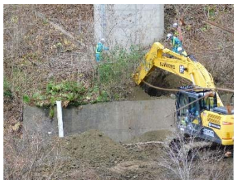
P1橋脚試掘状況
