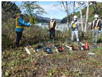
写真2 伐採作業状況 (作業前ミーティング)
