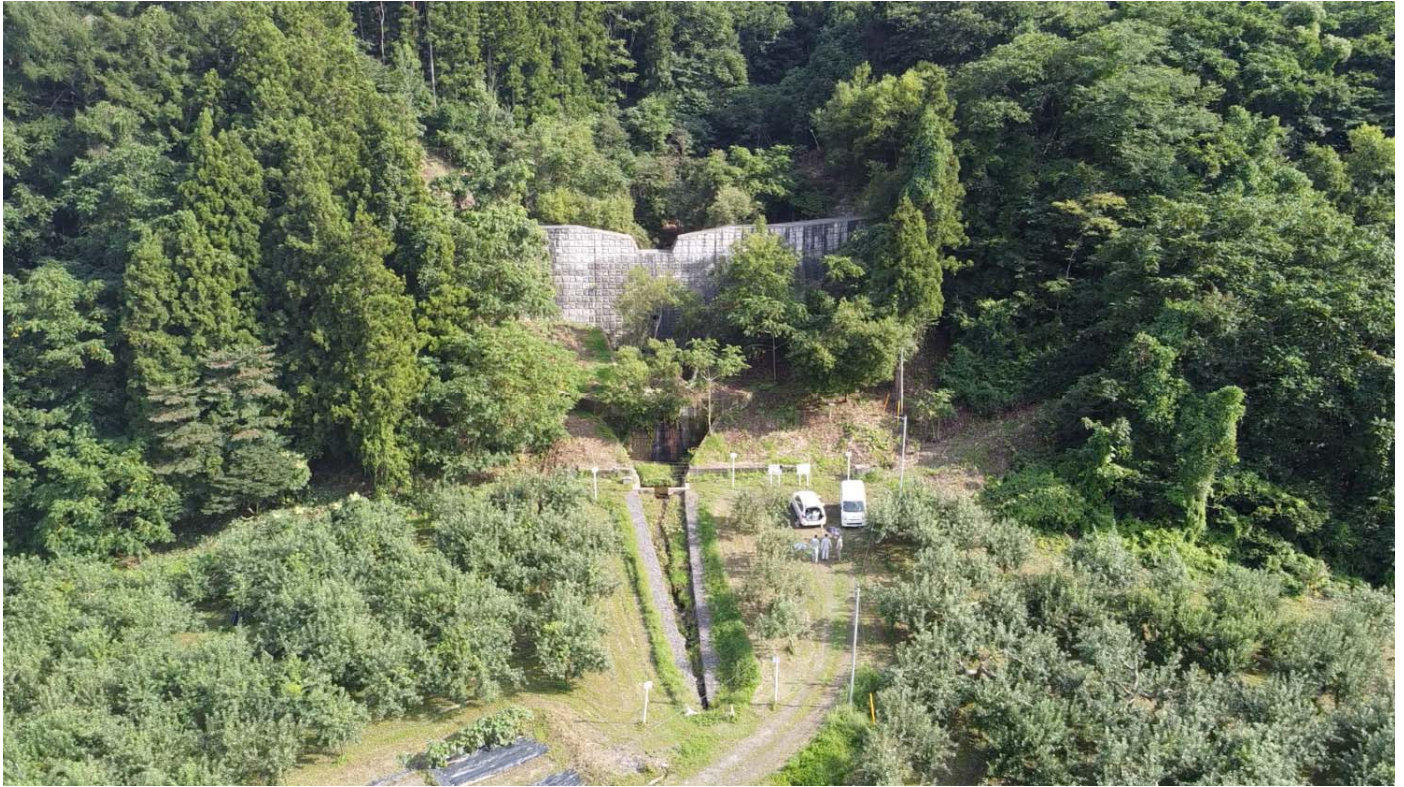
写真-1 UAVにより撮影した堰口沢砂防堰堤（現況）
