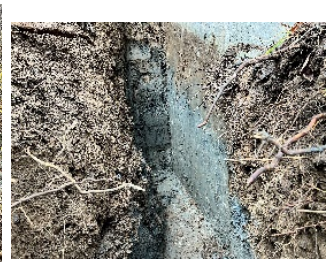
P3橋脚フーチング上面確認
