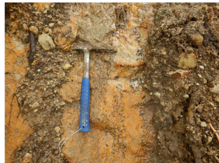
写真8 風化凝灰岩の拡大写真。ハンマー打撃で濁音、ポロポロに砕ける。
