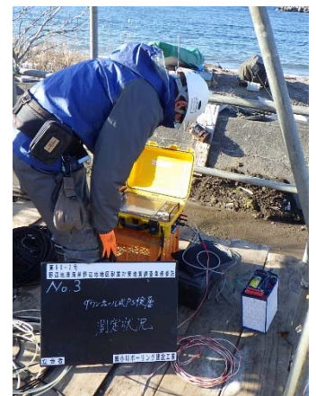
P・S検層状況写真
