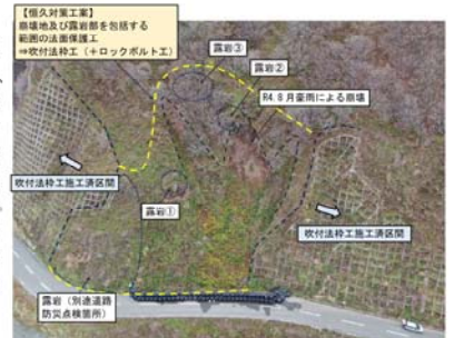
図 3-11 被災箇所全景写真
