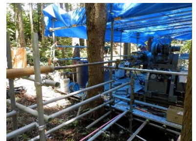
B-5 水平ボーリング 掘進状況
