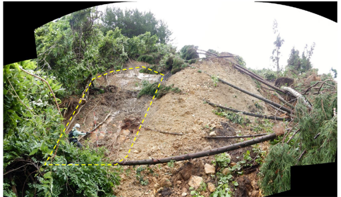
写真7 起点側の末端部の崩壊。崩壊面は基盤である風化凝灰岩（黄範囲）が露出している。
