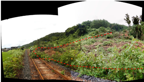
写真5 JR路線部。道路から西に約20m位置、道路比高+2m程度あるが、崩壊土砂が乗り上げている。線路上に高さ1.5m程度まで堆積している。
