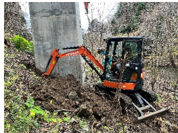
P3橋脚試掘状況
