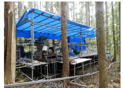
B-5 水平ボーリング 足場仮設
