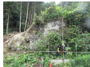
転石及び斜面の状況
