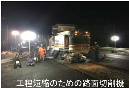
工程短縮のための路面切削機
