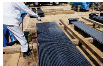
鉄筋の防錆処理
